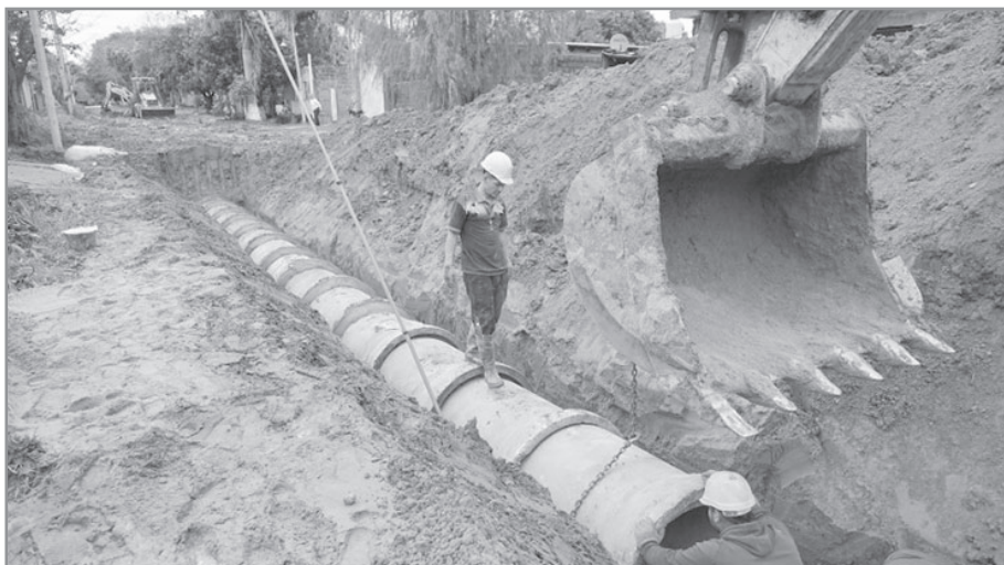
EN EJECUCIÓN. La intervención contempla la colocación de más de 400 metros de cañerías de hormigón y se complementa con los 600 metros ya colocados en la zona.
