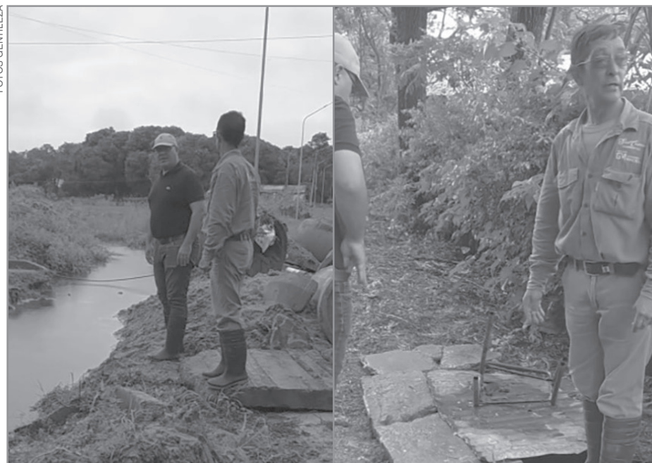
OPTIMIZANDO TIEMPO. El funcionario supervisa los diferentes trabajos desplegados.
