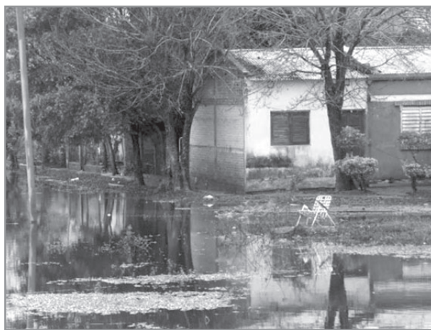
MARCO. Construcciones sobre predios inseguros.
