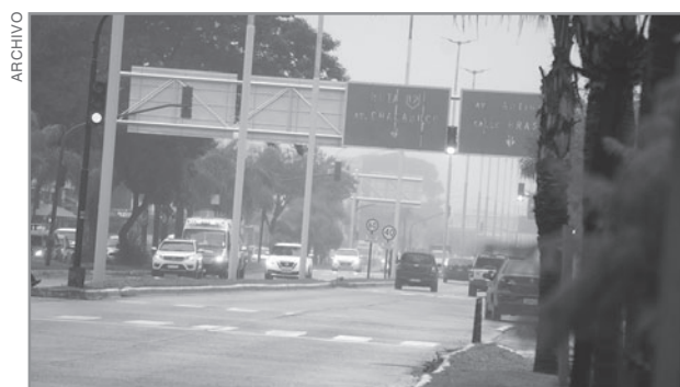
CORREDOR BELGRANO. Crecen las expectativas acerca de una pronta solución a la situación del mantenimiento de la vía que une la ruta 12 y el puente.
