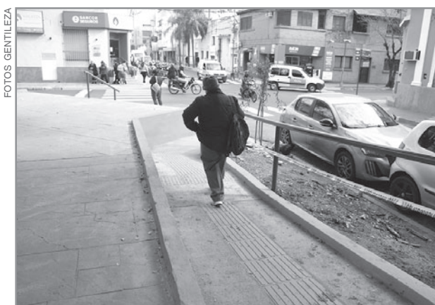
RAMPA. Las obras se realizaron en la plaza Torrent.
