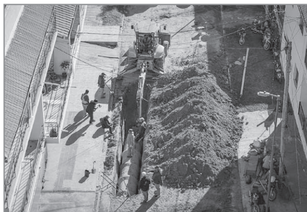
OBRAS PLUVIALES. El esquema de drenaje está diseñado para recolectar el agua de los puntos más deprimidos de la cuenca y transportarla hacia el conducto de la arteria principal, el cual vierte finalmente los caudales en el sistema Frondizi-Pirayuí.
