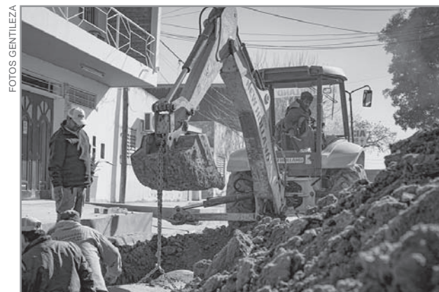
OBRAS PLUVIALES. El esquema de drenaje está diseñado para recolectar el agua de los puntos más deprimidos de la cuenca y transportarla hacia el conducto de la arteria principal, el cual vierte finalmente los caudales en el sistema Frondizi-Pirayuí.
