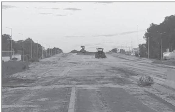
"RESURRECCIÓN". Tras una larga espera, la Autovía 12 comenzó a mostrar signos de reactivación, con maquinarias, tractores y movimientos de suelo.
