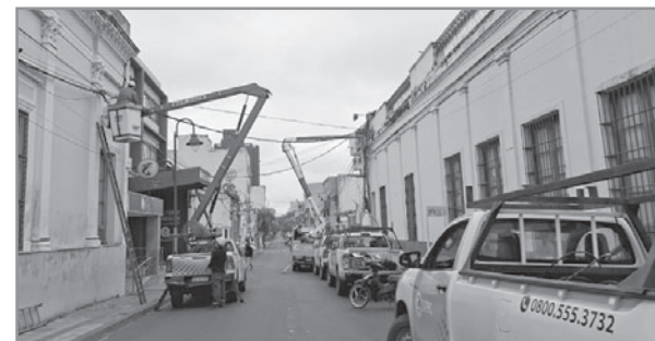
DESPLIEGUE. La colocación de postes y cableado.
