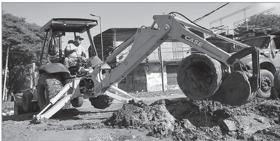
OBRAS PLUVIALES. Estas labores de nivelación, limpieza y colocación de tubos son fundamentales para garantizar el correcto escurrimiento del agua y evitar anegamientos durante las lluvias.
