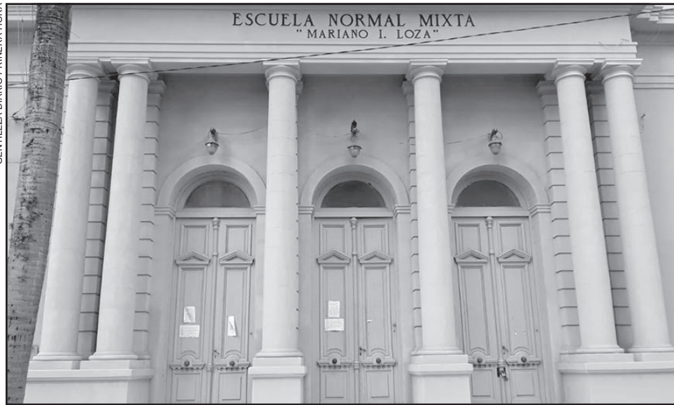
VENERABLE EDIFICIO. Las instalaciones de la Escuela Normal Mariano I Loza albergarán hoy a los integrantes de la Cámara baja de la Provincia de Corrientes.
